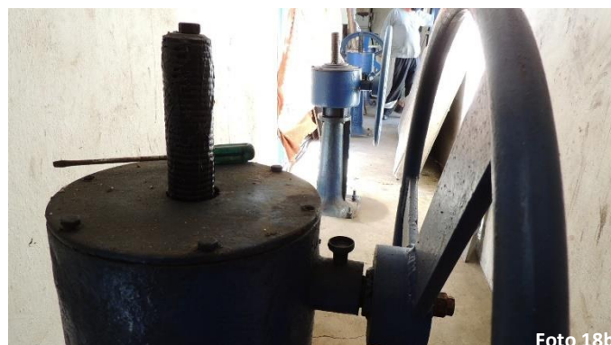
Área interna da comporta e sistema de abertura e fechamento
