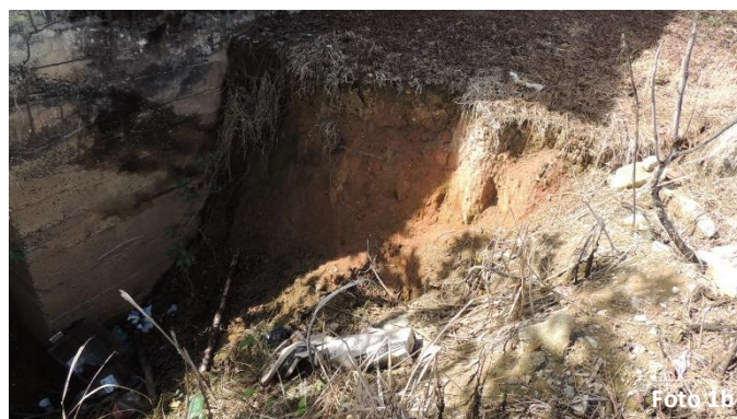
Estrutura externa da comporta e Solo cedendo em frente a estrutura da comporta
