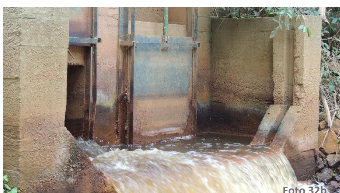
Lado de adução da comporta, devido a comporta aberta a água estava saindo do canal e retornando para o rio Paraíba do Sul
