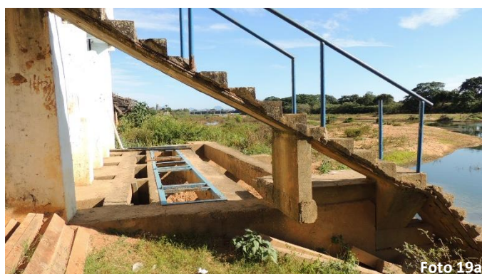
Estrutura de acesso e pontos com ferragens expostas
