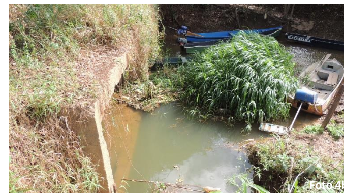
Estado aparente do sistema de adução, mostrando assoreamento na entrada da comporta do lado esquerdo
