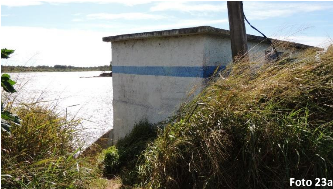
Estrutura da comporta com proliferação de vegetação
