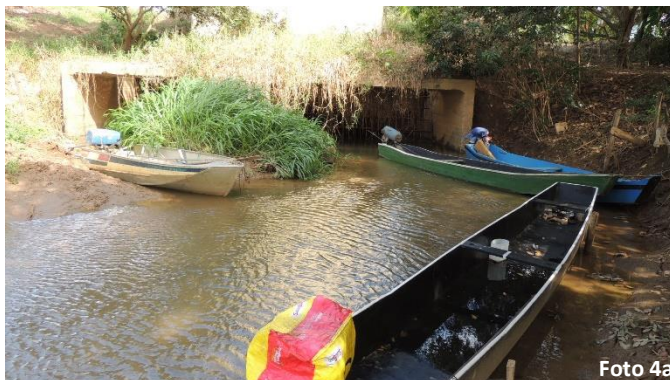
Estado aparente do sistema de adução, mostrando assoreamento na entrada da comporta do lado esquerdo
