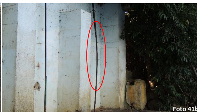
Estruturas de abertura e fechamento das comportas vandalizadas
