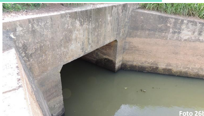
Trecho inicial do canal com assoreamento
