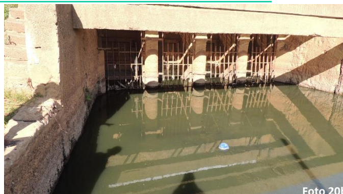
Lado de adução da comporta e parte onde pode ser observado a entrada de esgoto retornando do canal
