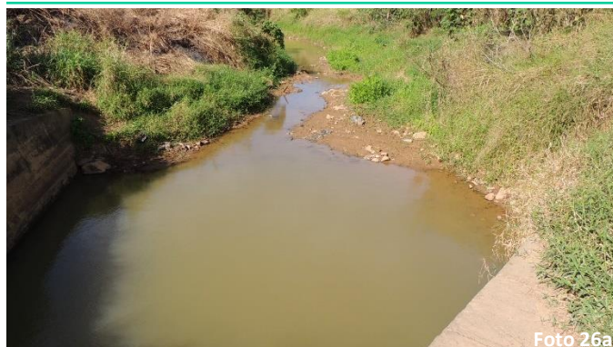
Trecho inicial do canal com assoreamento
