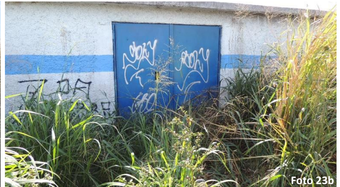
Estrutura da comporta com proliferação de vegetação
