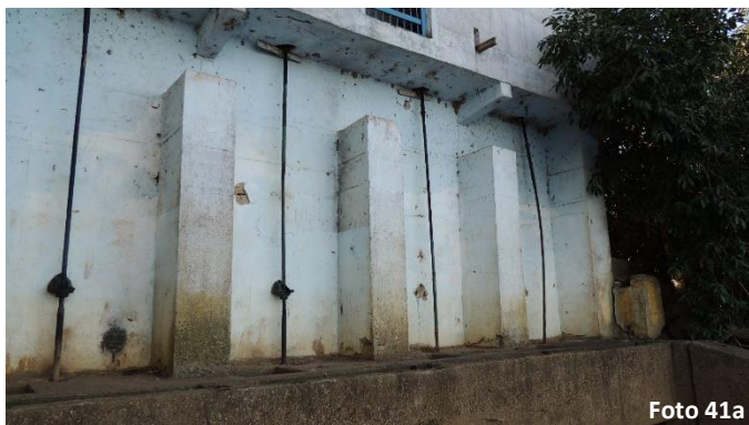
Estruturas de abertura e fechamento das comportas vandalizadas
