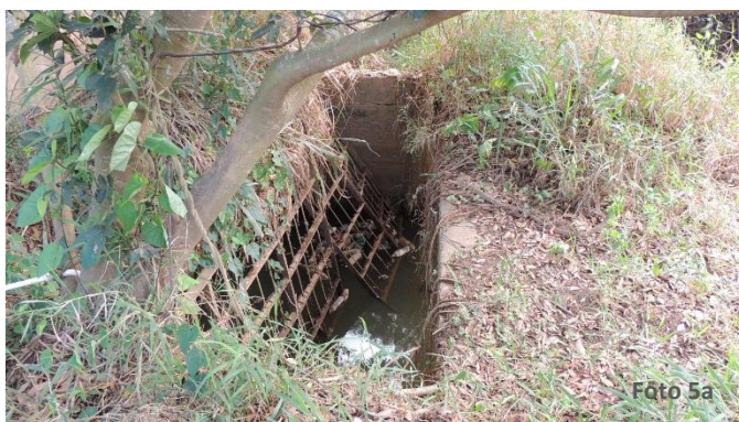
Estado aparente do sistema de adução, mostrando assoreamento na entrada da comporta do lado esquerdo
