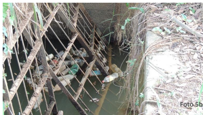
Estado aparente do sistema de adução, mostrando assoreamento na entrada da comporta do lado esquerdo
