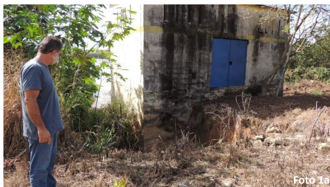
Estrutura externa da comporta e Solo cedendo em frente a estrutura da comporta
