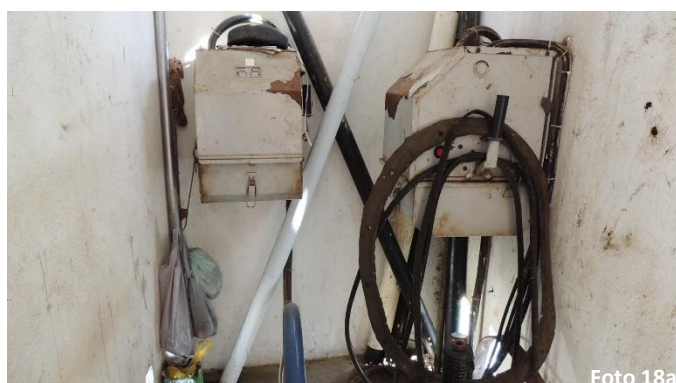
Área interna da comporta e sistema de abertura e fechamento
