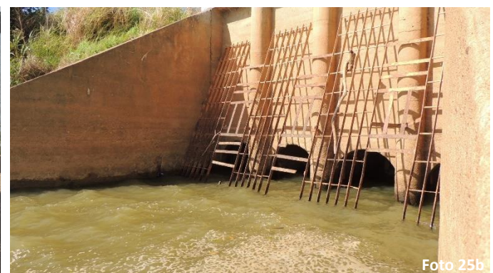
Trecho de adução da comporta e grades de proteção vandalizadas para acesso a parte interna da comporta
